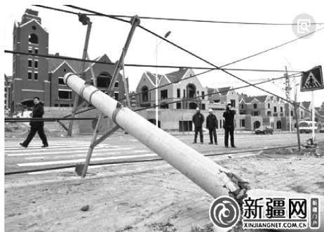
图2 被风刮断的电线杆
